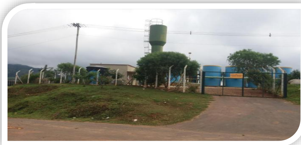
ESTACÃO DE TRATAMENTO DE ÁGUA - JECEABA
