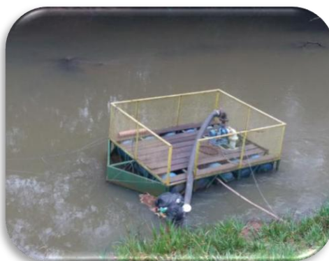
BALSA DE CAPTAÇÃO
